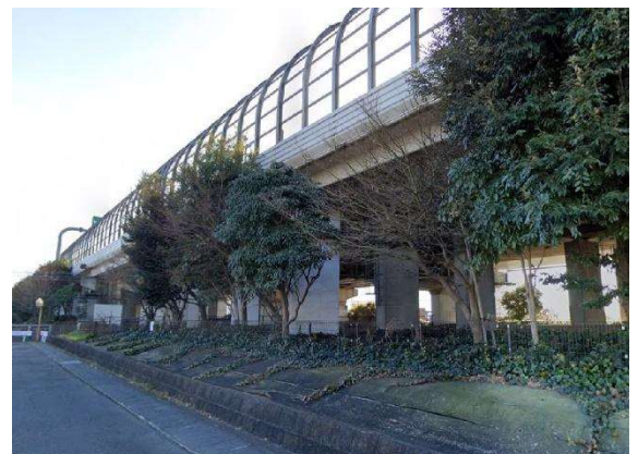
船子高架橋の 3 柱式橋脚 (Google ストリートビューより)
