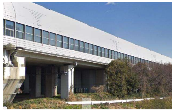
船子高架橋の3柱式橋脚(Google ストリートビューより)
